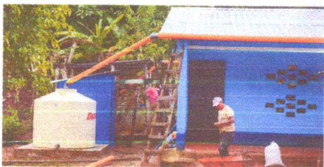
Foto 3: Colocacion de tinaco, canales y finalizacion de ducha.
