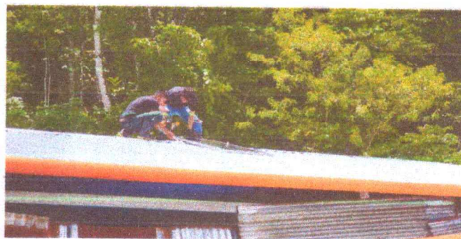
Foto 4: Colocacion y reparacion de panel solar.
